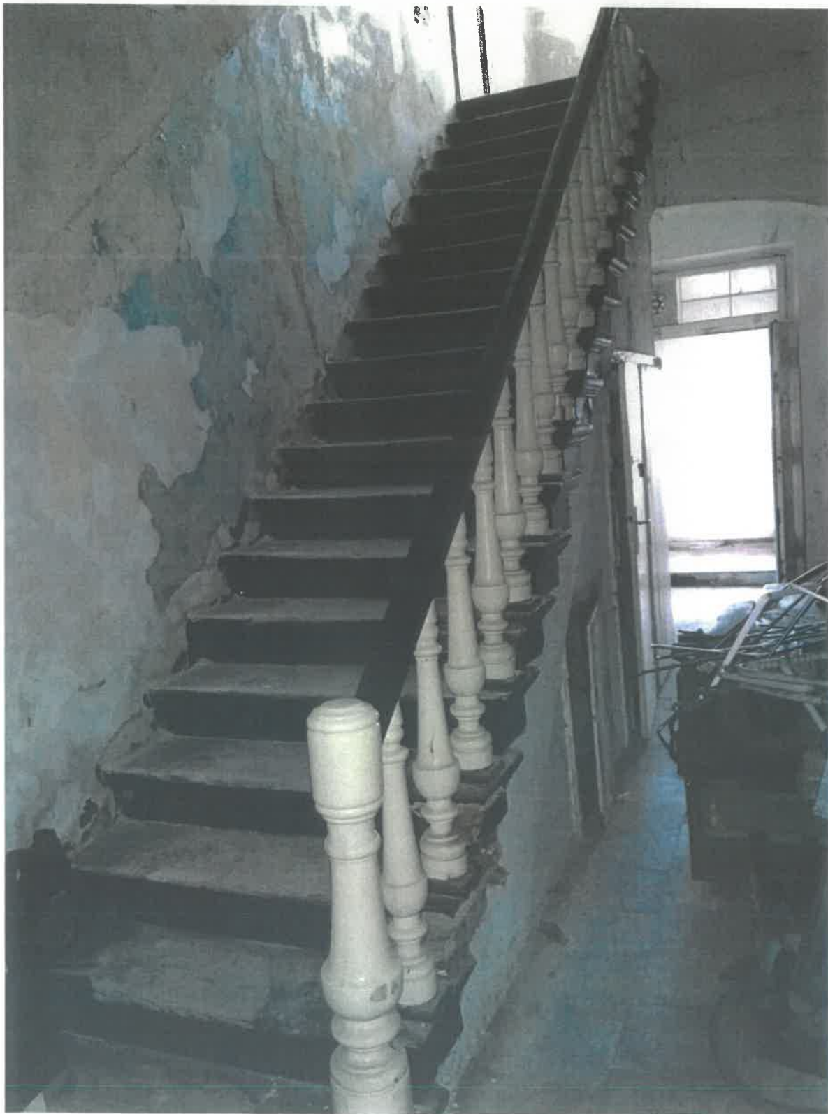
Fot/Rys - 3-6 Widok ogólny – schody na piętro
