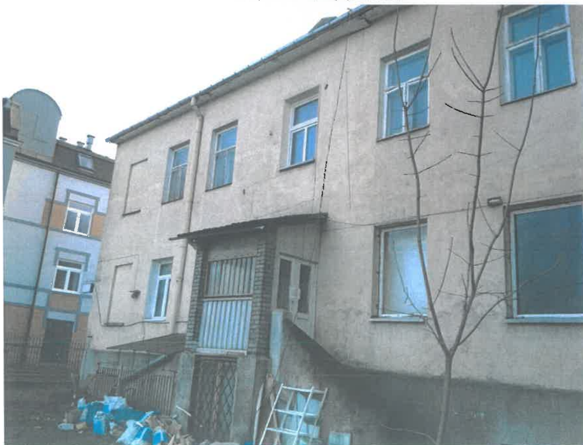
Fot/Rys - 3-20 Elewacja północna
