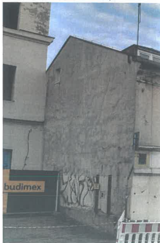
Fot/Rys - 3-22 Elewacja wschodnia
