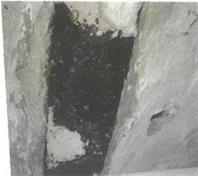
Fot/Rys - 3-4 Belki stropu Kleina
